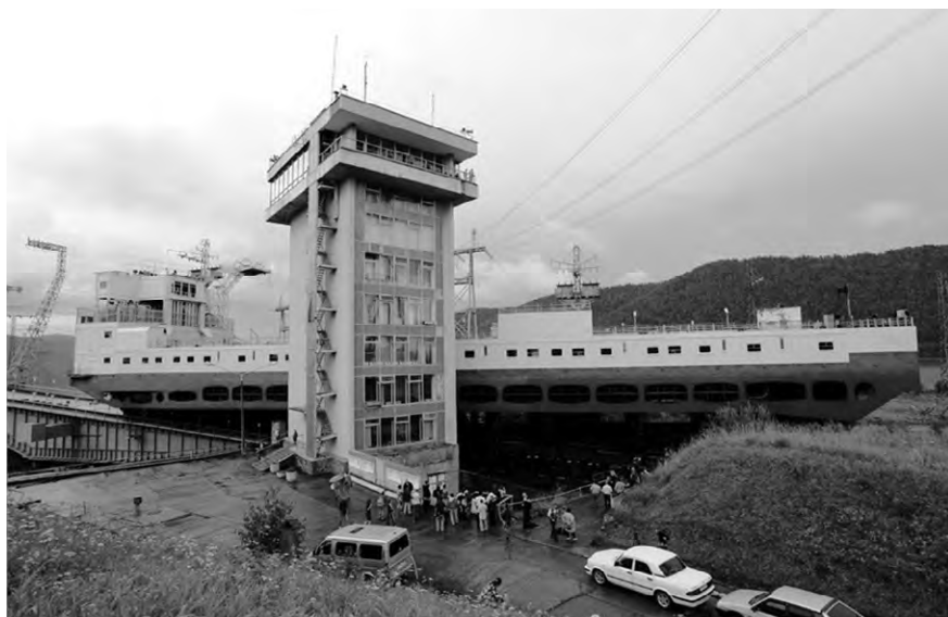
Управление эксплуатации Красноярского судоподъемника
