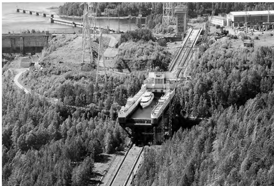
Судоподъёмник Красноярской ГЭС
