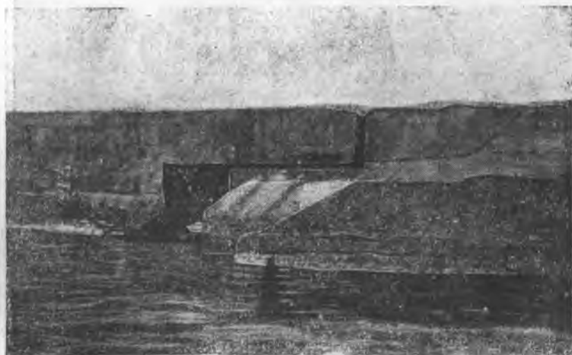
Рис. 46. Брешь в гиганте № 79 (вид со стороны моря)
