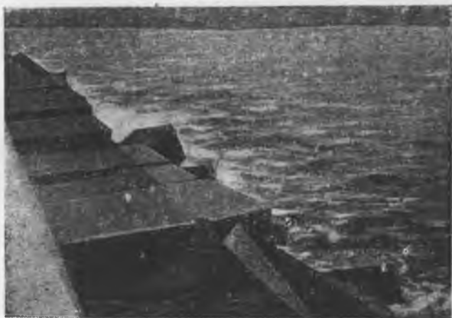
Рис. 193. Расслаивание массива
