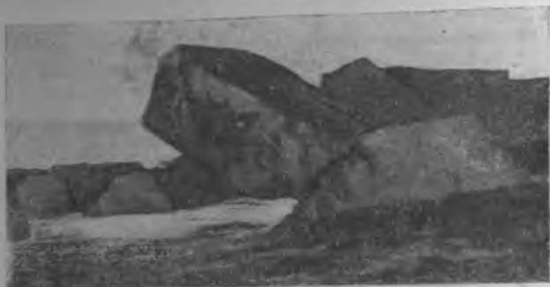
Рис. 118. Обломки мола после аварии
