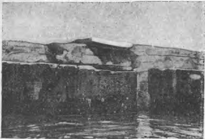
Рис. 31. Откол и сдвиг парапета у шва гигантов № 19 и 21 (вид со стороны порта)
