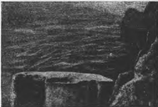
Рис. 194. Повреждения массива в районе пазов
