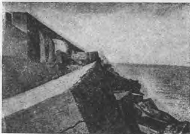
Рис. 192. Начало расслаивания массива
