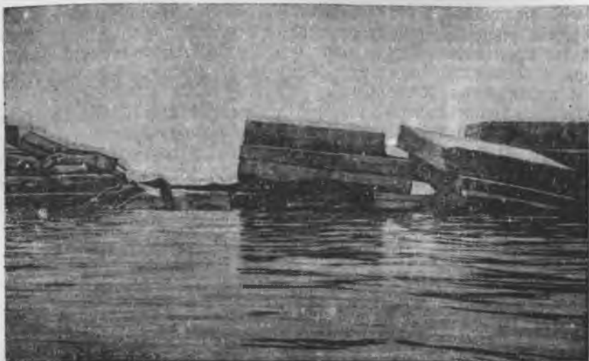
Рис. 40. Разрушенная заделка малой бреши
