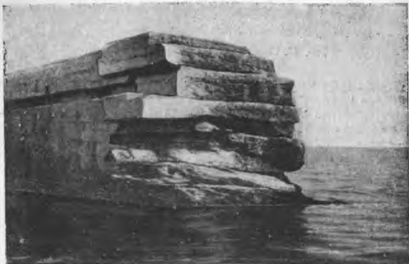
Рис. 47. Брешь в гигантах № 84—75 (вид гиганта № 84 со стороны порта)
