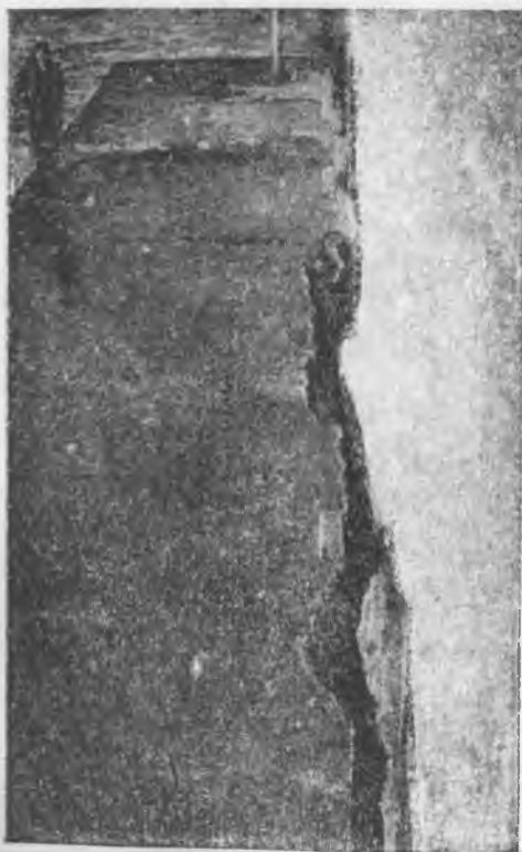
Рис. 39. Щель между гигантом № 98 и надводной стенкой
