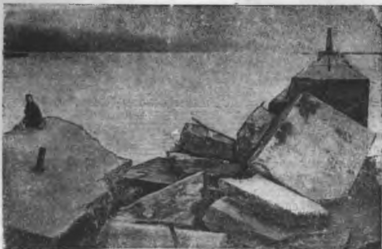
Рис. 41. Разрушенная заделка малой бреши
