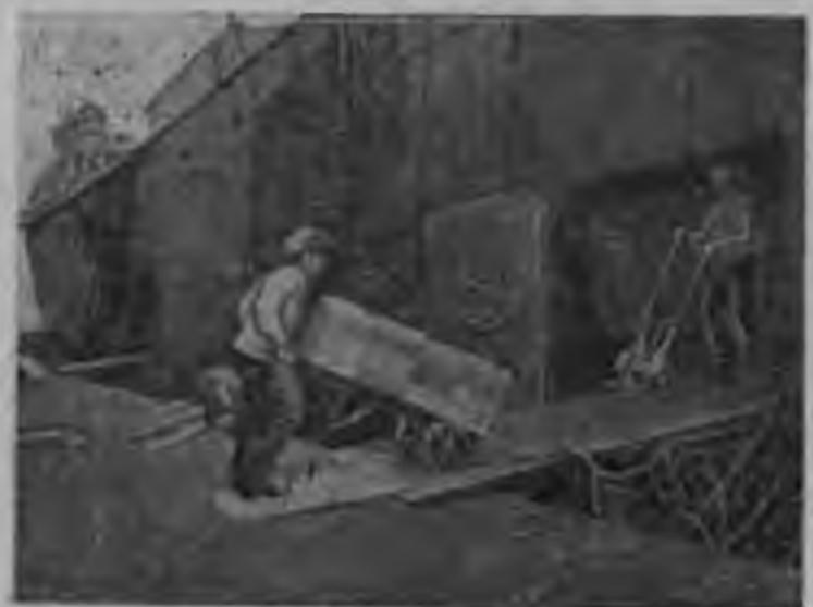
Рис. 90. Вкатывание тележки с прикордонной полосы внутрь судна через борт-люки.
