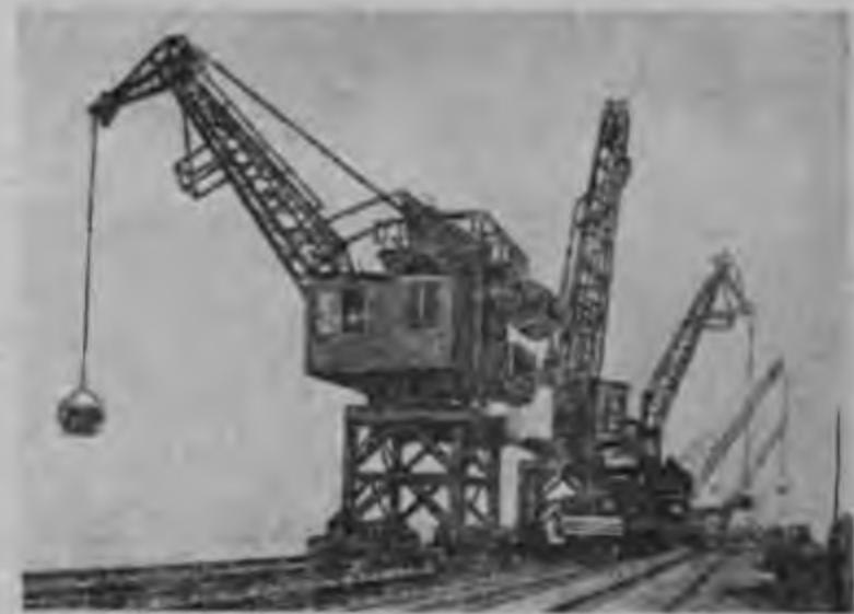
Рис. 136. Оборудование причального фронта для перевозки тяжеловесов посредством порталовых кранов.
