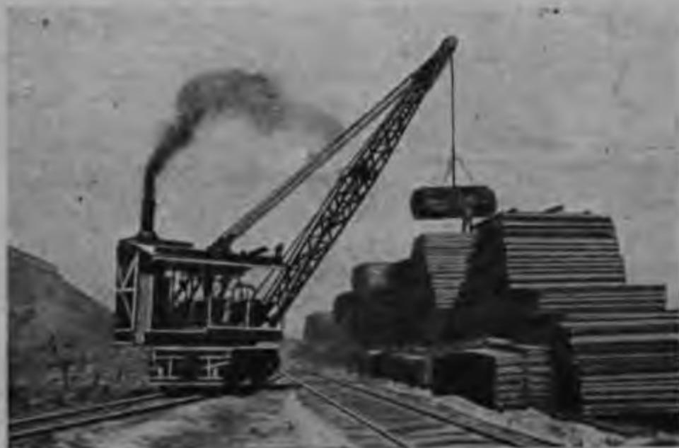
Рис. 332. Поворотные катучие жел.-дор. краны для лесных складов.
