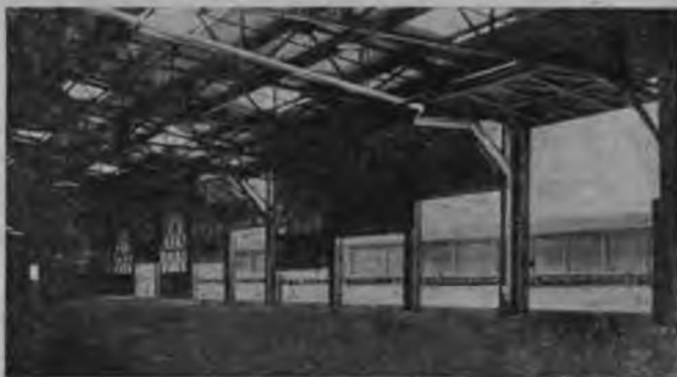
Рис. 82. Устройство опрокидывающихся (turn over door) дверей в американских павесах и складах.
