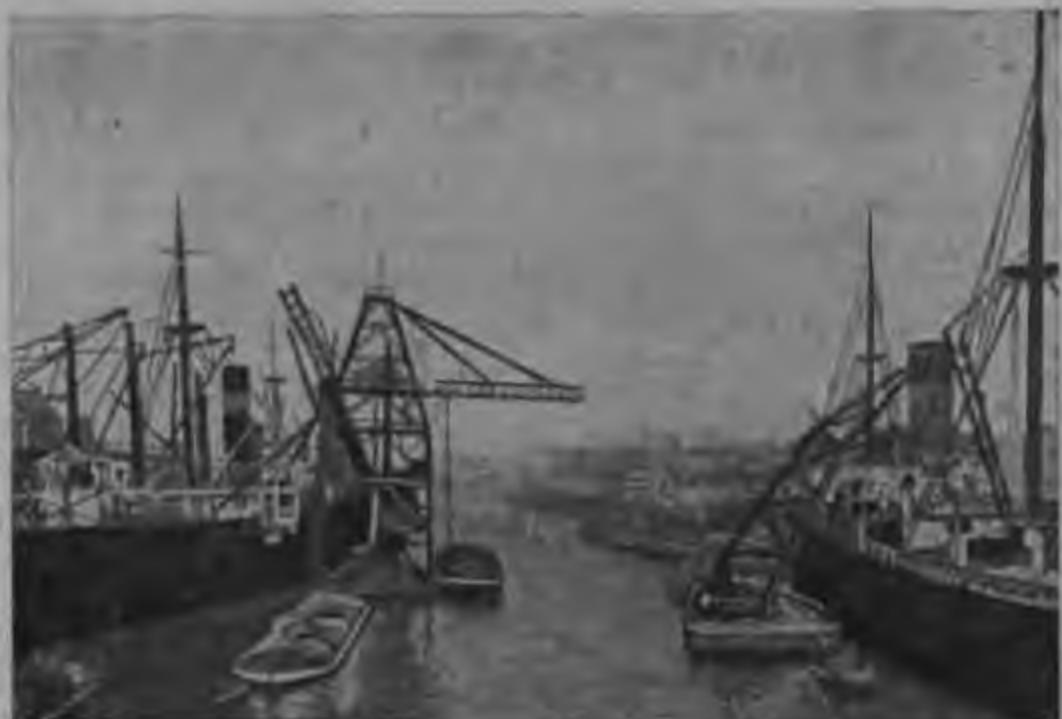
Рис. 387. Пловучий углоперегружатель (без запасов угля на себе) по схеме перегружочного моста с тележкой.
