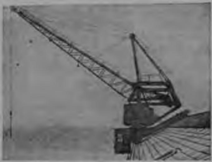
Рис. 58-б. Общий вид кровельного крана.
