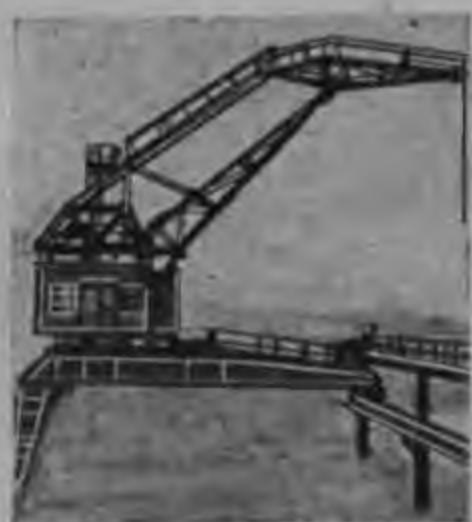
Рис. 53. Тип берегового полу-портального крана с гибкой укосиной герм. завода Демаг.
