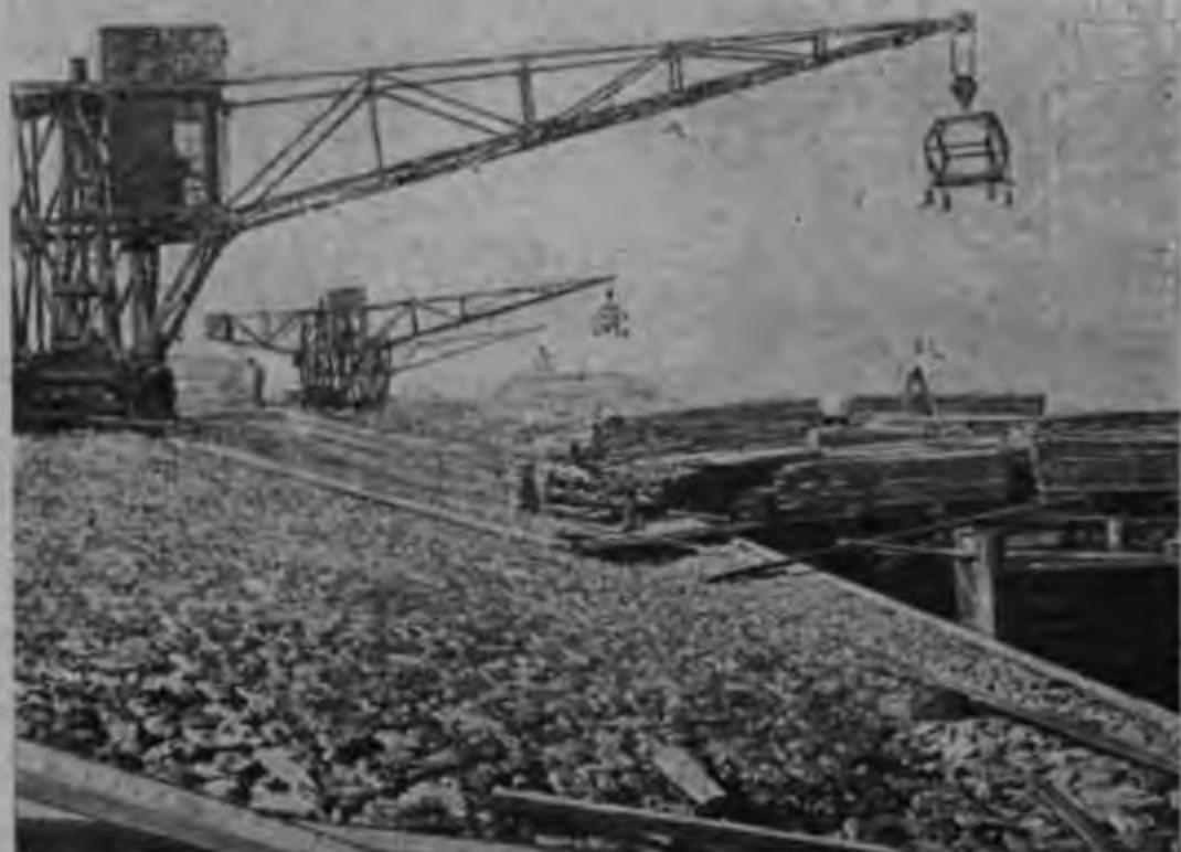
Рис. 336. Поворотный катучий кран для выгрузки пачек пиломатериалов из баржей.
