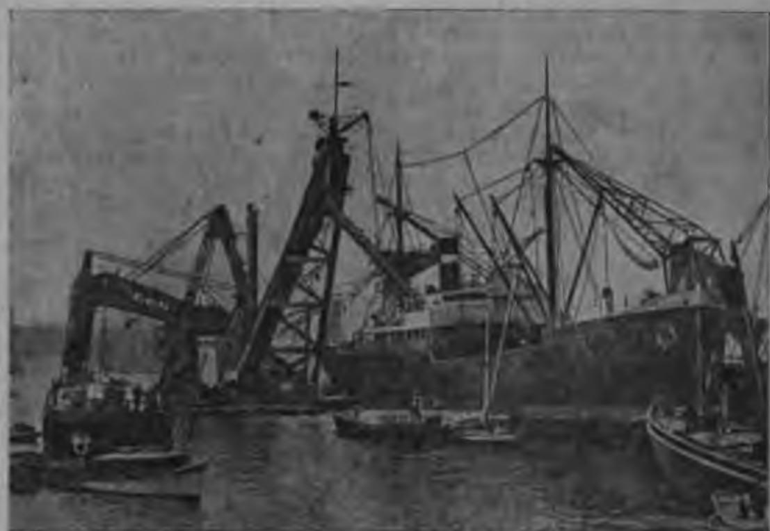
Рис. 382. Пловучий углеперегружатель с запасом угля в своих трюмах (угольщик-перегружатель).
