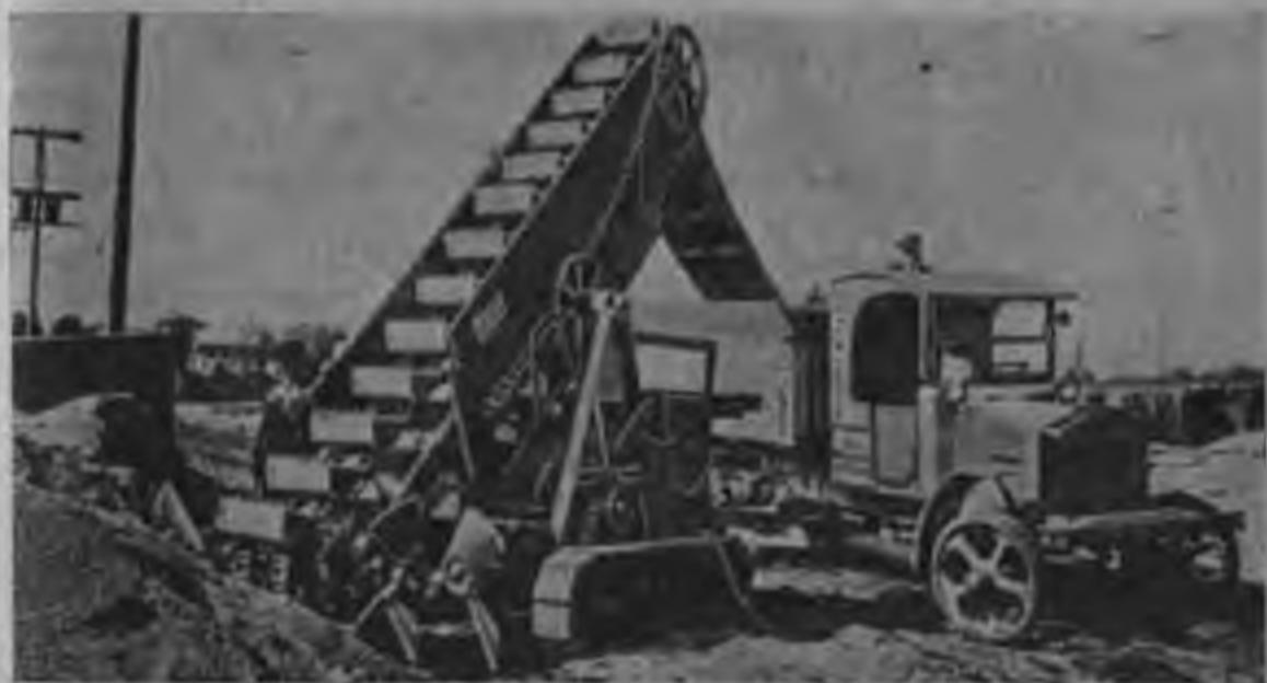
Рис. 292. Подвижной ковшевой подъемник (системы Haiss или Heinzelman) для погрузки навалочных грузов из склада в вагоны.
