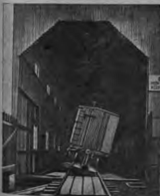
Рис. 174. Тип торцово-бокового вагоноопрокидывателя для выгрузки зерна.
