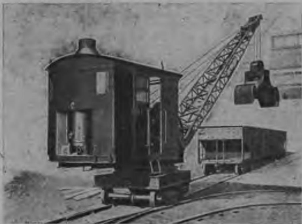
Рис. 281. Извлечение угля из полувагонов с помощью жел.-дор. крана с грейфером.
