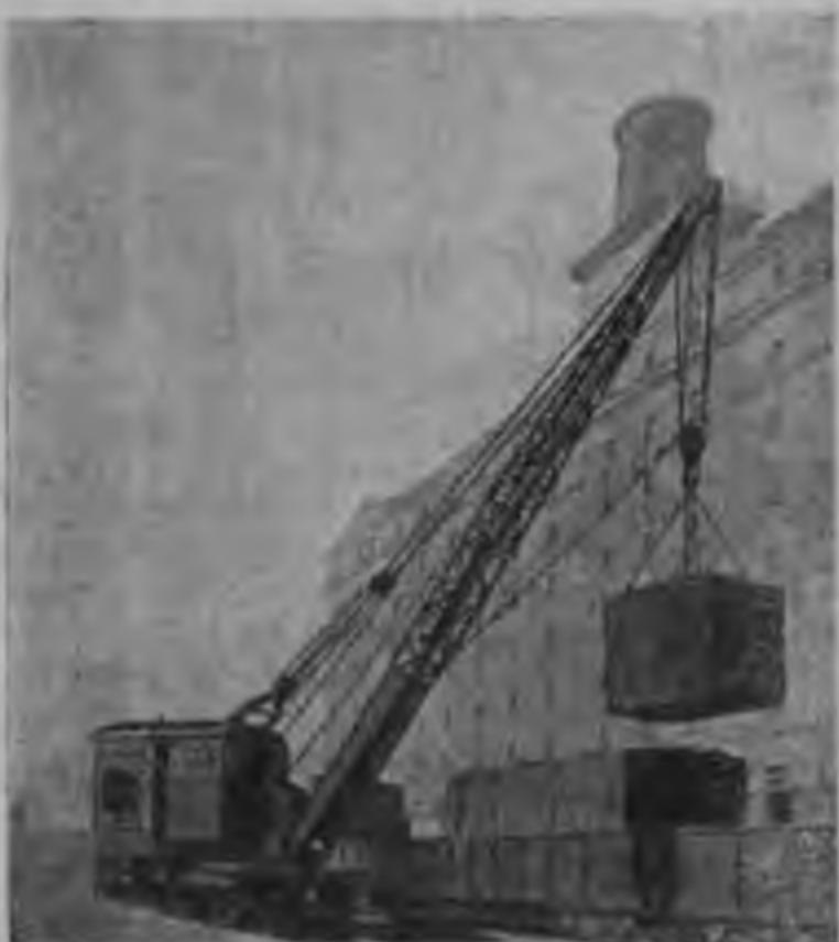
Рис. 14-б. Установка контейнеров на подвижном составе краном.
