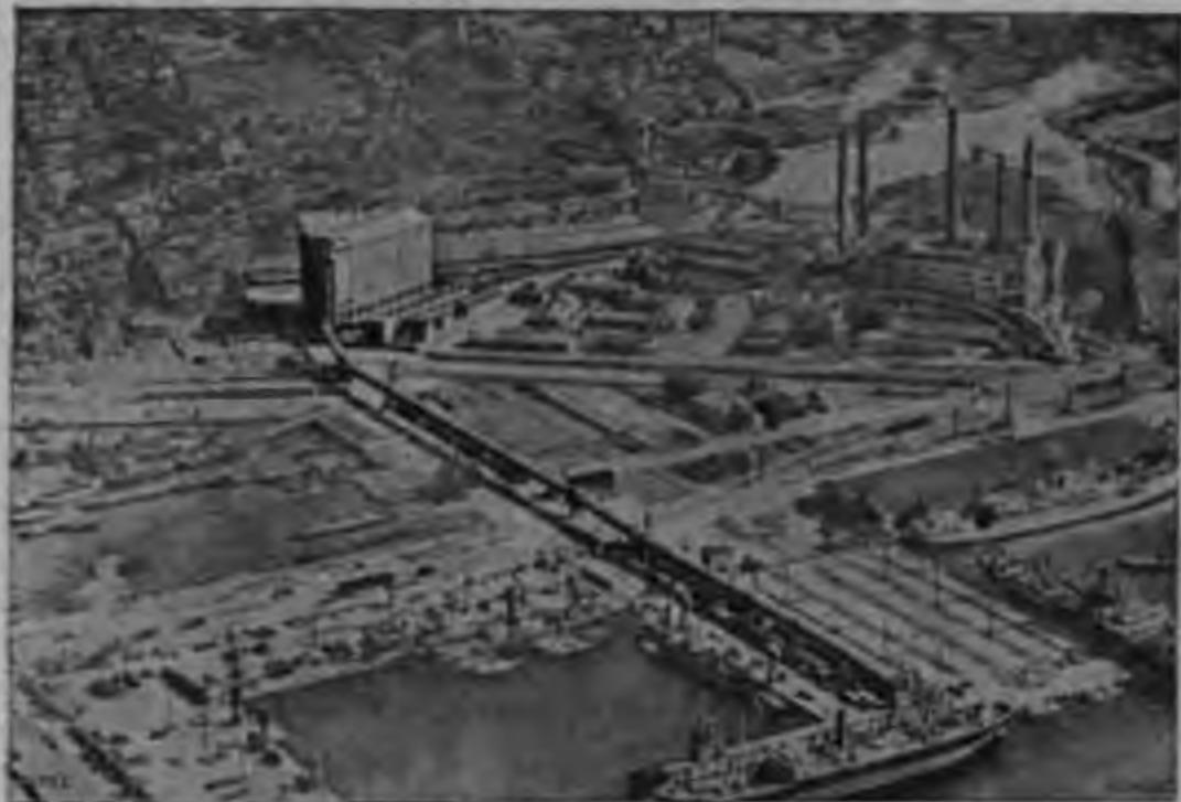
Рис. 162. Общее расположение элеватора в Марсельском порту с комбинированной системой пневматической и механической выгрузки зерна из судна.
