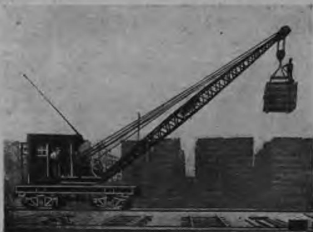
Рис. 344. Катучий жел.-дор. электрический кран на лесном складе.
