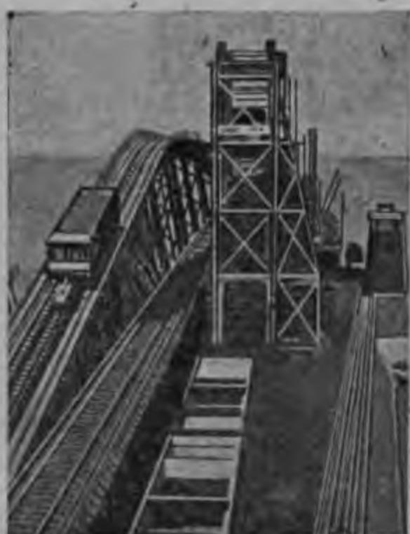
Рис. 233. Подъем вагонов на эстакаду по наклонной плоскости или вертикальным лифтам.
