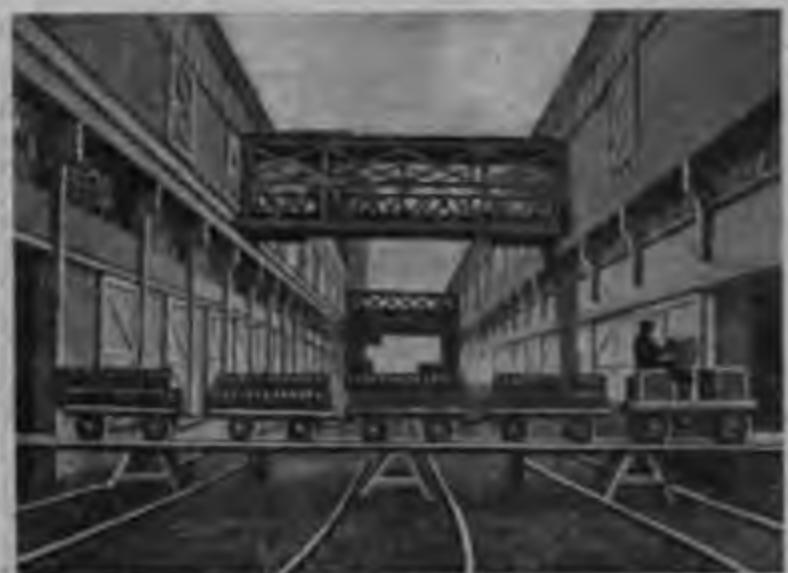
Рис. 37. Передача грузов из складов одной линии в склады другой помошью подвижных и переставных мостиков.
