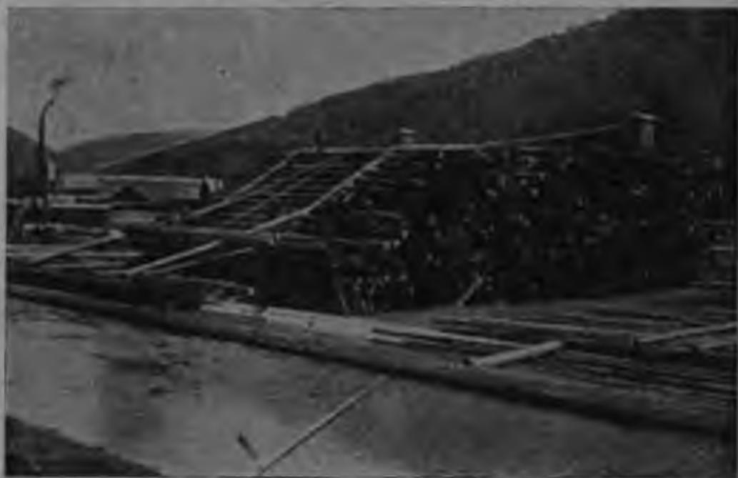
Рис. 313. Общий вид штабеля круглого леса, сложенного посредством раскаточных лебедок (видны верхушки их башен на заднем плане).
